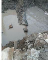
8月12日 下午3时,该路 段 DN1000 管线 又一次被损坏, 造成大面积停水 情况。公司得知 该消息后,立即 组织维修人员及 维修车辆进场查 看情况,在第一 时间了解损坏情 况,迅速制定施 工方案。由于施 工现场情况比较 复杂,直至次日
