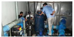
二次供水管理部秦刚部长第一时间赶赴现场指挥泵房抢险工作。根据现场实际情况,与维修班长一起商讨制定了泵房抢修及临时恢复供水方案。确定了以现有水箱底层 1 米为高度,打孔安装遥控浮球阀,进行水位控制,临时恢复泵房供水。从 18 时开始,停中、高区供
