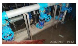
水,只保留低区供水,进行浮球阀安装作业,19 时 20 分左右,浮球阀安装完毕,恢复整个小区供水,保证了小区居民的用水需要。
