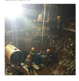
310 国道改线工程是为配合连盐铁路建设,将连盐铁路两侧原 DN800 管线改为南侧 DN1000 管线、北侧 DN800 管线的工程,整个工程需安装 DN1000 球管 150 米,DN1000 钢管 192 米,DN800 钢管 204 米。由于 310 国道南侧铁路东侧管线埋深约 4 米,改管管材为壁厚 12mm 钢管,施工方案相当复杂,施工难度大大增加;同时,改线工程与铁路建设存在多项交叉作业工作,导致改线工程无法连续作业。为保证项目工期,源通人面临时间紧、难度大、任务重、协调难度大等多重压力。
